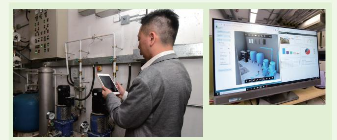
管理人員透過「BIM設施管理系統」的三維模型,便可在電腦平台實時監測建築物內不同系統及設施的狀態,或控制開 關。
